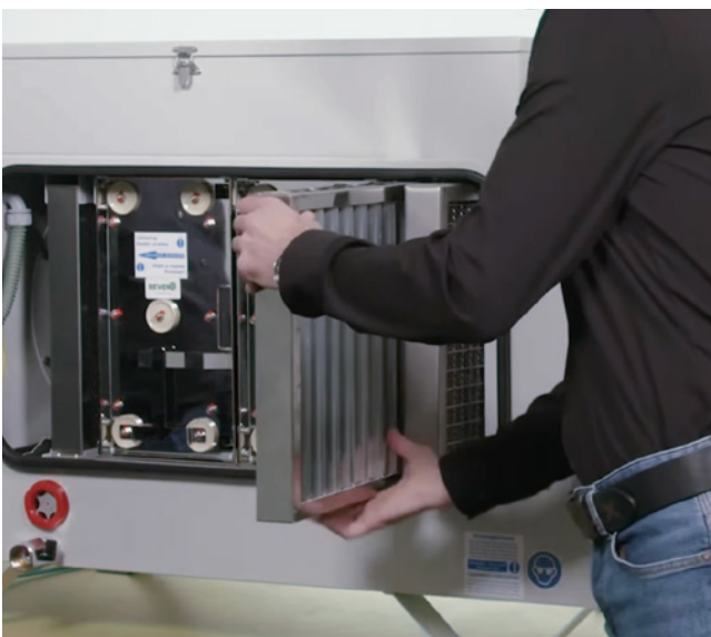
Der X-CYCLONE® Abscheider kann leicht aus einem industriellen Luftreiniger herausgezogen werden.
