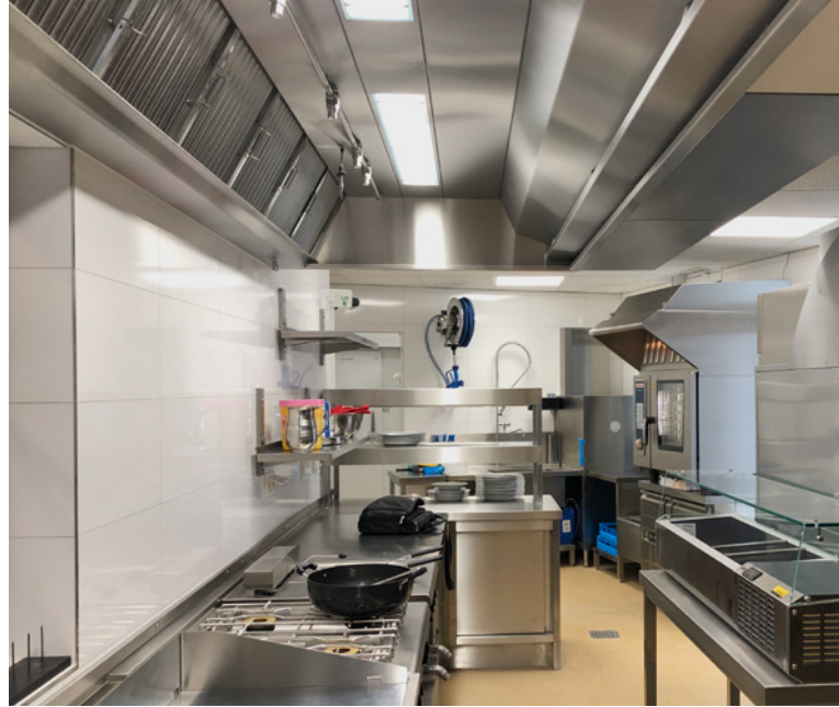
Induktionshaube mit integrierter Feuerlöschanlage
