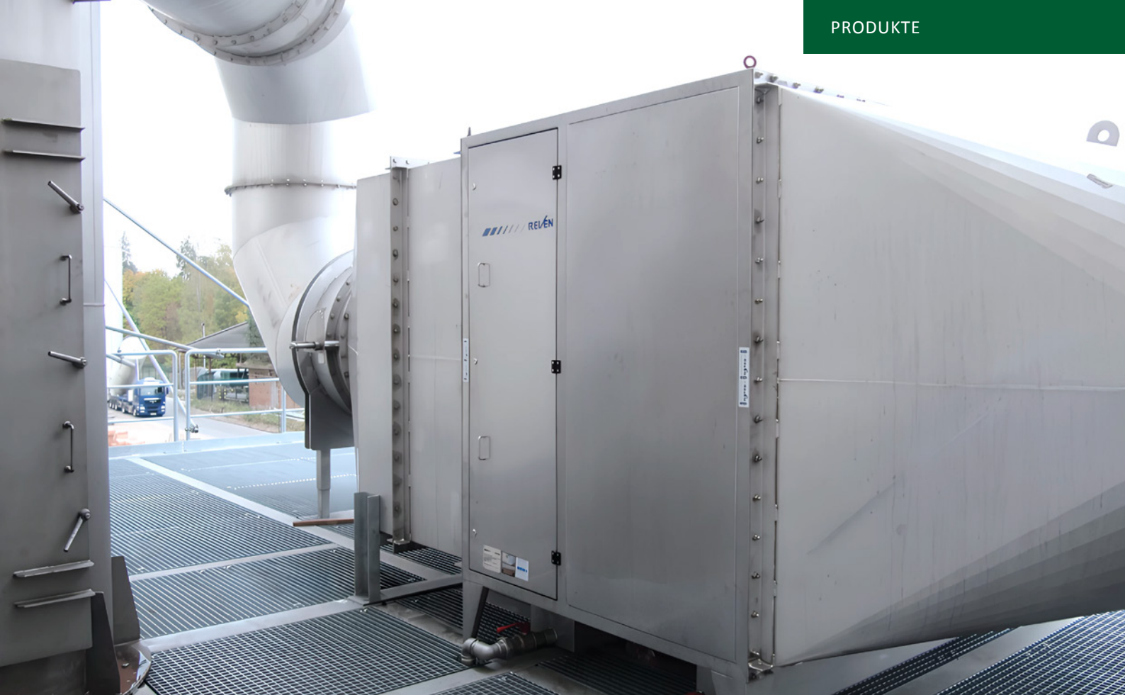
X-CYCLONE® RKM Abluftkanalreiniger aus sehr hoch legiertem Edelstahl 1.4571 für den Einsatz bei sehr hohen Abluftmengen
