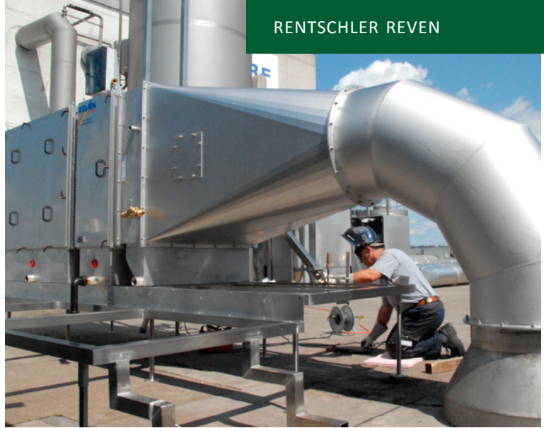
Abluftkanalreiniger in der Lebensmittelindustrie
