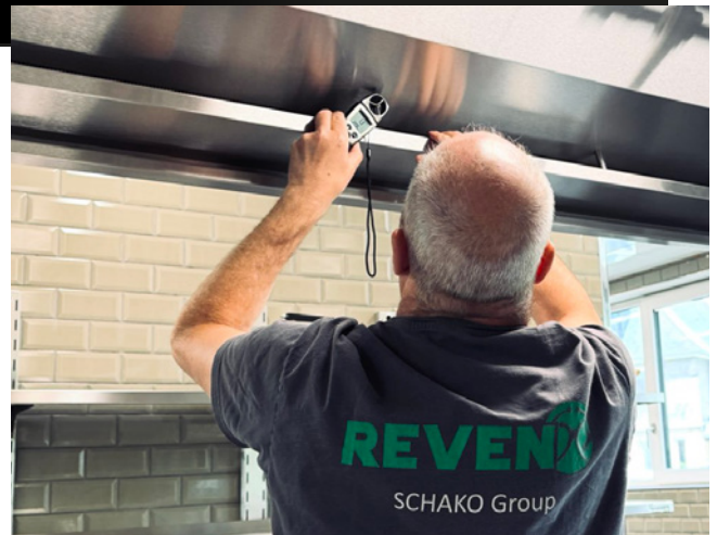
Letzte Prüfung einer eingebauten Induktionshaube
