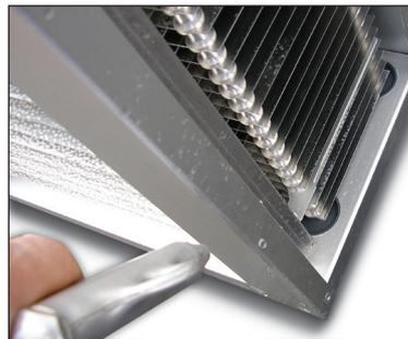
Es ist darauf zu achten, dass die Kollektoren trocken sind, bevor sie eingesetzt werden.
