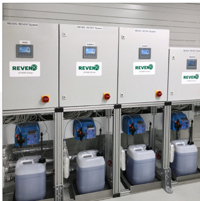
Abb.: Anordnungsbeispiel nebeneinanderstehender Dosierstationen von REVEX® Systemen für die Küche, für die Bereiche Ausgabe 1 und Ausgabe 2 und für die Gästeküche
