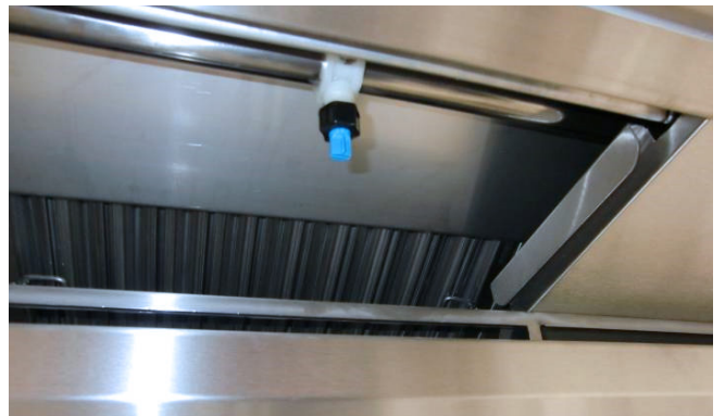
Abb.: Blick in eine REVEX® Haube „vor dem Abscheider“
