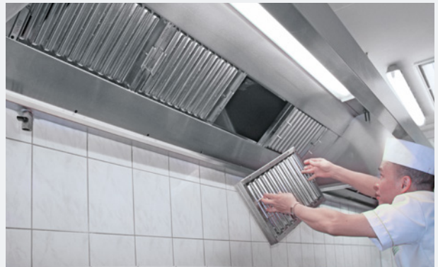
Abb.: Aerosolabscheider müssen nicht einzeln herausgenommen und in Spülmaschinen gereinigt werden.
