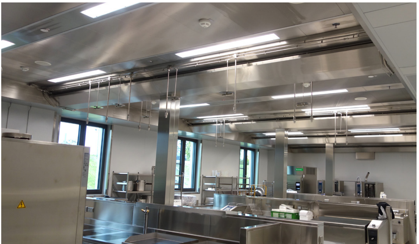
Abb.: REVEN Lüftungsdecke mit RESEX® Spühsystem im Red Bull in Leipzig
