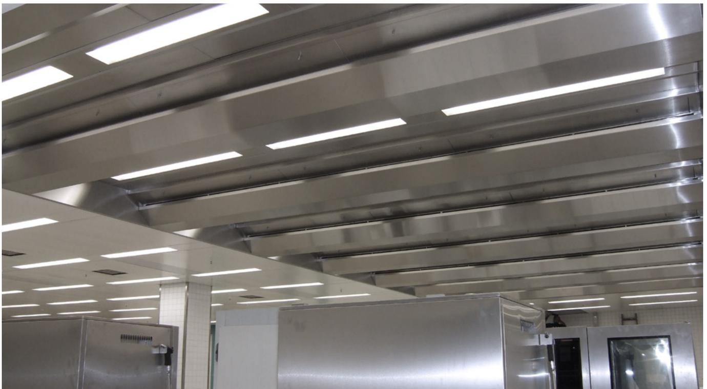
Abb.: Lüftungsdecke mit Abluft-Deckenmodulen X-CYCLONE® DR und Zuluftinduktions-Deckenmodulen REVEN® DVN
