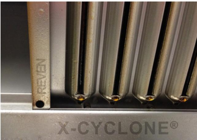
Abb.: X-CYCLONE® Aerosolabscheider im Einsatz.
