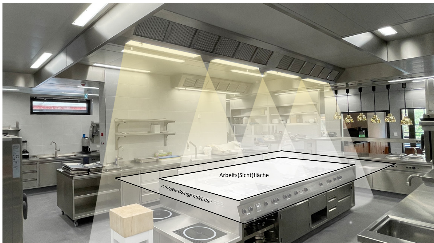
Abb.: Bei der Berechnung für eine Arbeitsfläche muss der angrenzende Bereich, die Umgebungsfläche (eine virtuelle Umrandung der Arbeitsfläche) mindestens 50 cm betragen. Die Beleuchtungsstärke für die Arbeitsfläche muss mindestens 500 Lux und für die Umgebungsfläche 300 Lux betragen.
