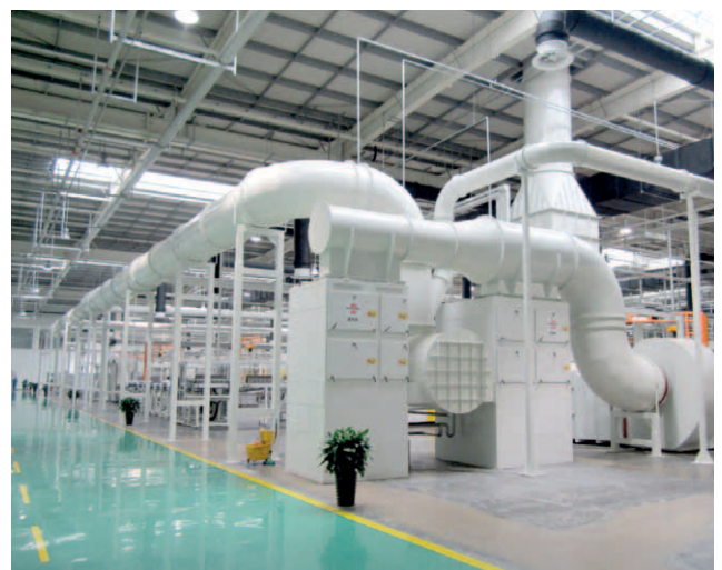
Bild 24 Zentral-Absauganlage
