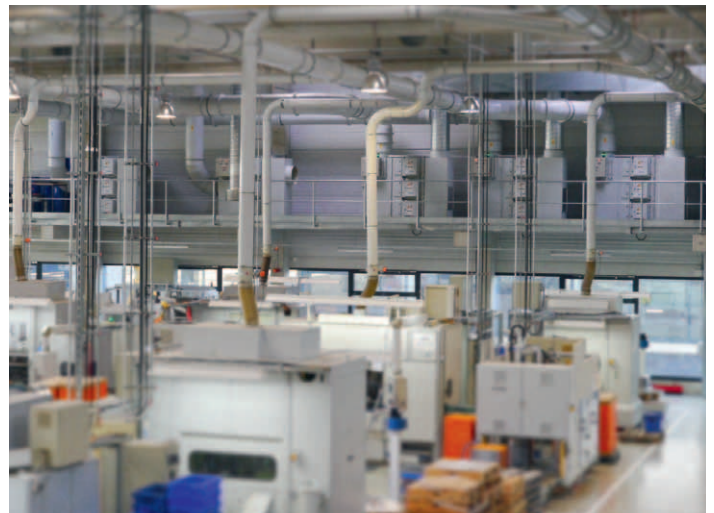
Bild 26 Zentral-Absauganlage
