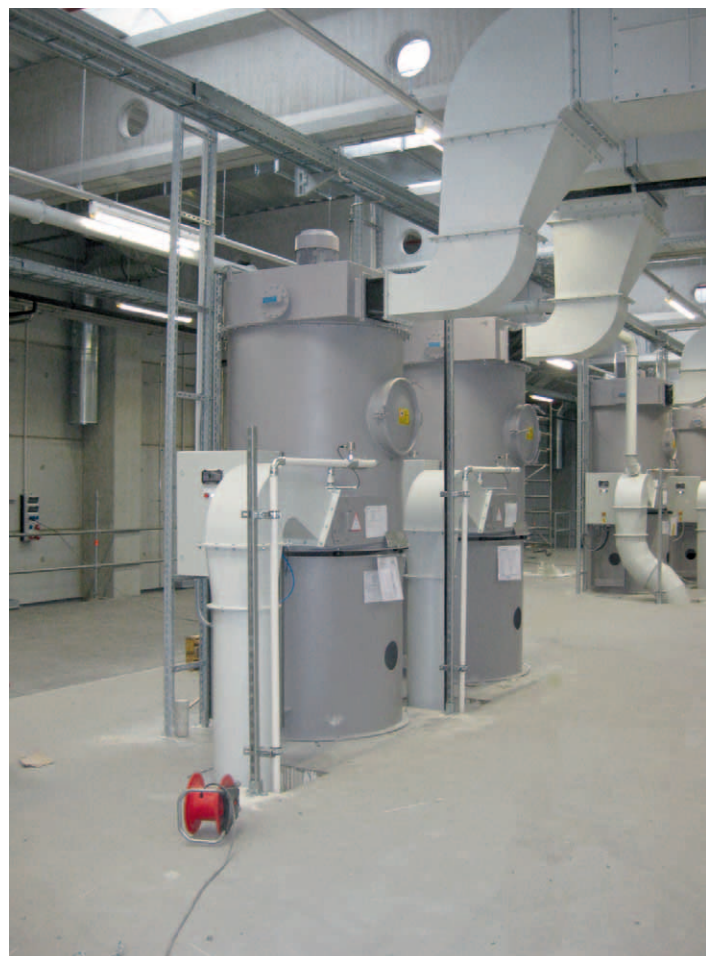
Bild 16 Funktionsprinzip Nassabscheider
