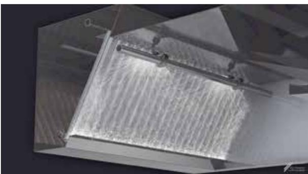
B) sie reinigt die Luft auf ähnliche Weise wie ein Luftwäscher in der Chemischen Industrie. Durch die permanente REVEX® Luftwäschefunktion werden kleinste Aerosole sowie schädliche Gase aus dem Luftstrom ausgewaschen.
